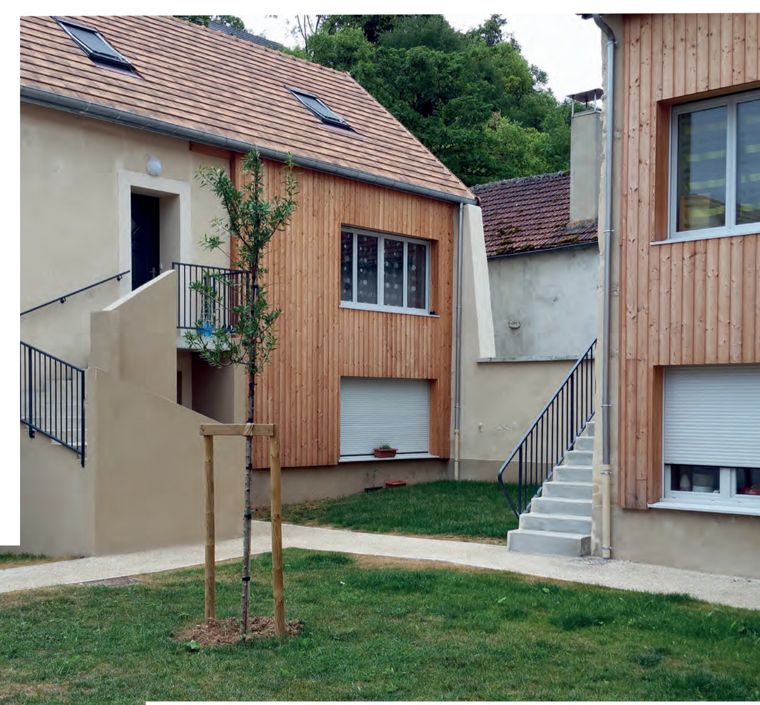
Corps de ferme réhabilité en logements à Guerville
