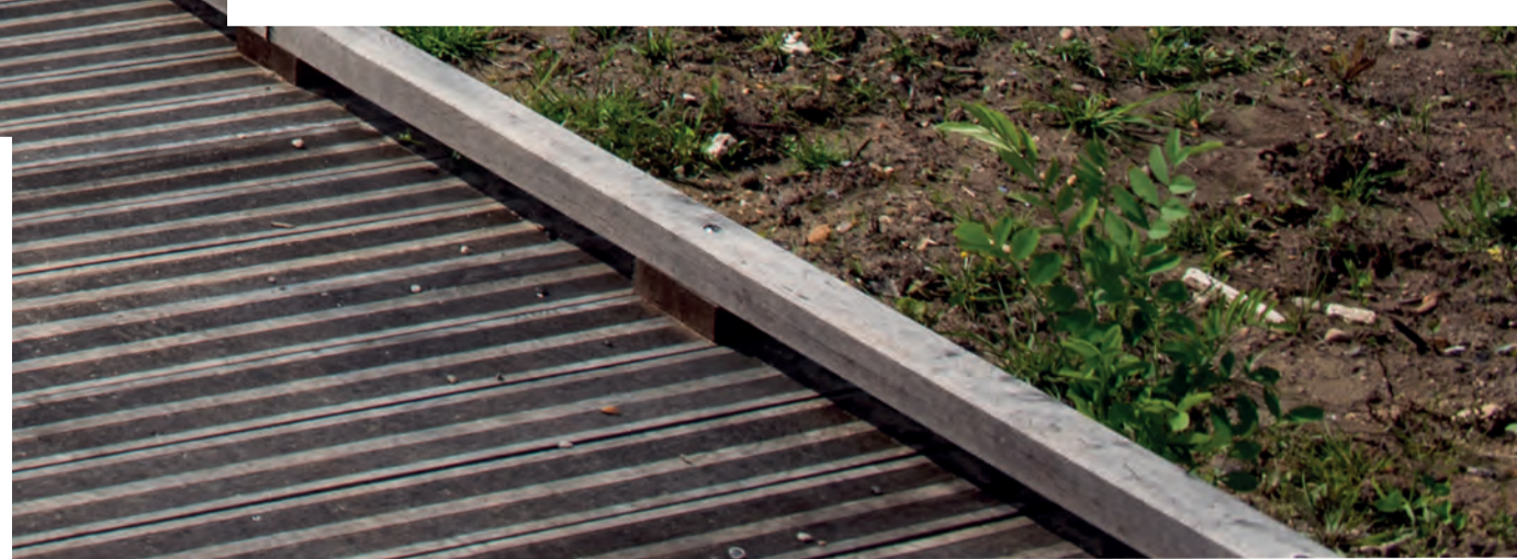
Aménagement en bord de Seine à Carrière-sous-Poissy © Agence TER / A. Petzold
