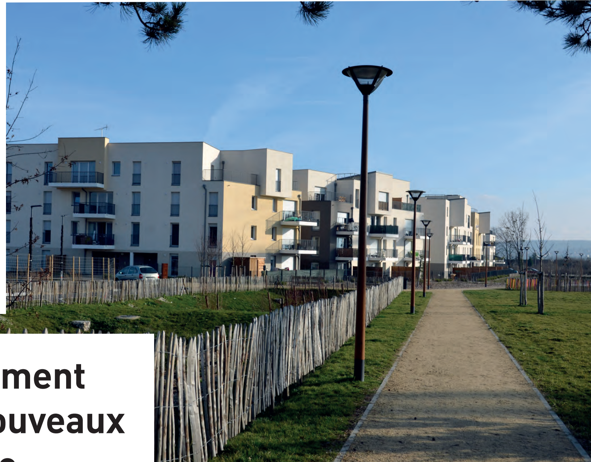
Les Hauts de Rangiport, un nouveau quartier bâti sur la friche Porcher à proximité de la gare à Gargenville
