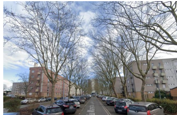
Vue intérieure du quartier depuis l'avenue du Maréchal Lyautey. Source : Google
